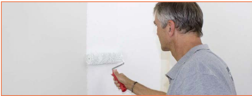
// Vorbereitung der Untergründe mit der Putzgrundierung.
